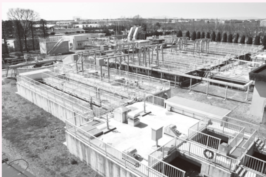
水処理センター
