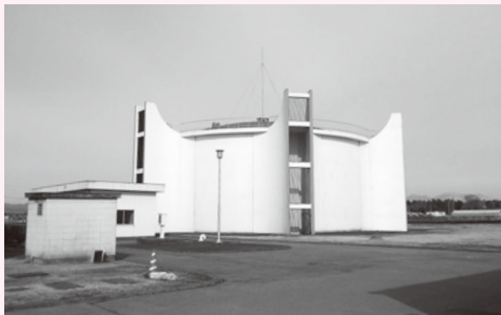
中央配水場の外観
