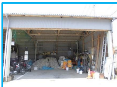
現本庁舎敷地内 土嚢等資材置き場
