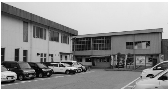
老朽化した現体育館。早期更新が望まれる。
