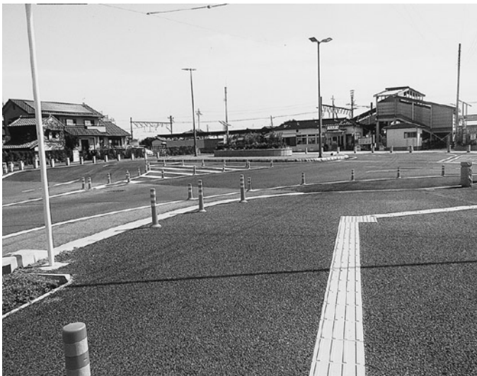
安塚駅西広場整備事業完成
