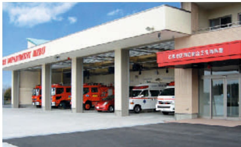
石橋地区消防組合壬生消防署庁舎
