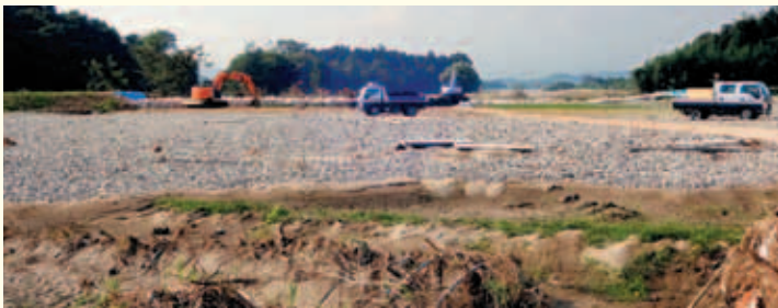
仮復旧作業中の堤防(福和田地内同上)
