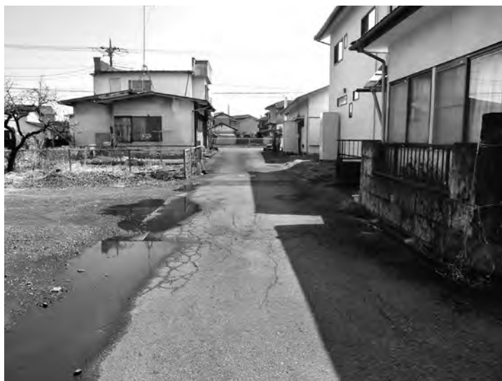
道路や側溝の傷みが顕在する住宅街（安塚地内）
