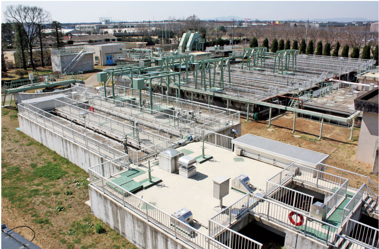
水処理センター
