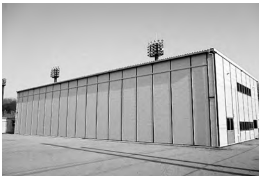
ボルダリング格納施設
